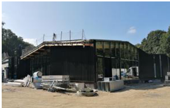
Façade en tôle noire de la piscine
