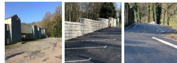
Avant travaux, après travaux
