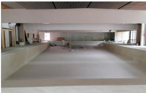
Pose de la résine dans le bassin
