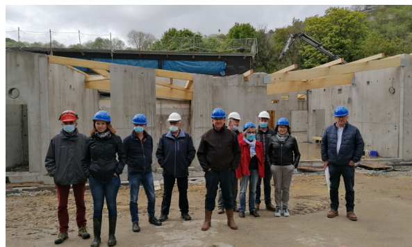
Viste du chantier par les élus, le 11 mai 2021
