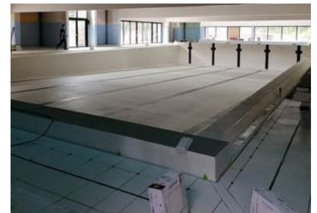
Pose du carrelage autour du bassin
