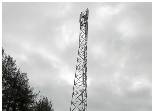
Antenne de Saint Goazec, le 30 novembre 2021
