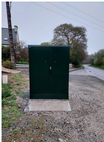
Point de Mutualisation, rue du Stade, Plonévez-du-Faou, installé en 2021
