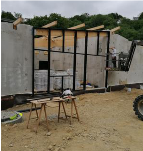
Mise en place de la structure métallique de la future verrière
