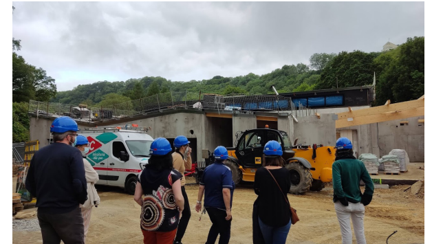
Viste du chantier par les agents, le 11 mai 2021
