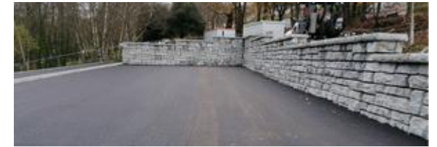
Mur extérieur, parking en cours de construction
