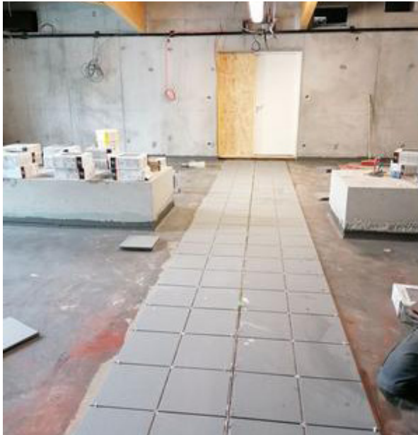
Pose du carrelage des vestiaires
