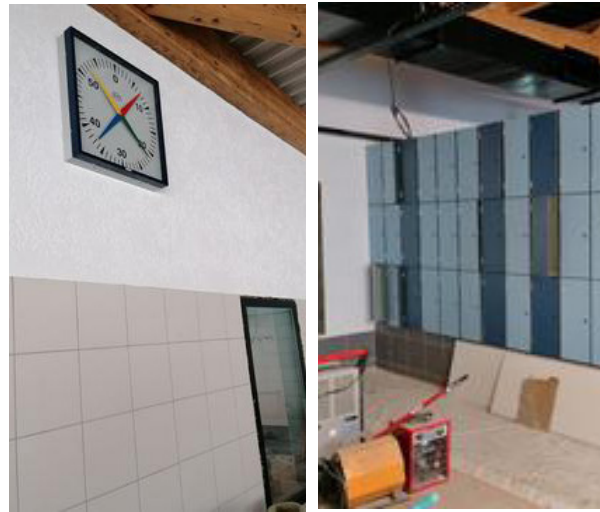
Mise en place du chrono et pose des casiers dans les vestiaires
