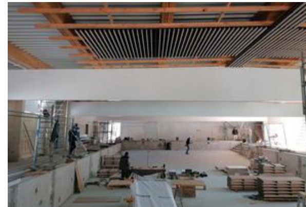
Installation du plafond avec marquage des lignes d'eau
